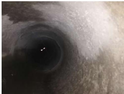
Foto 5 – tratto di fognatura da sostituire
